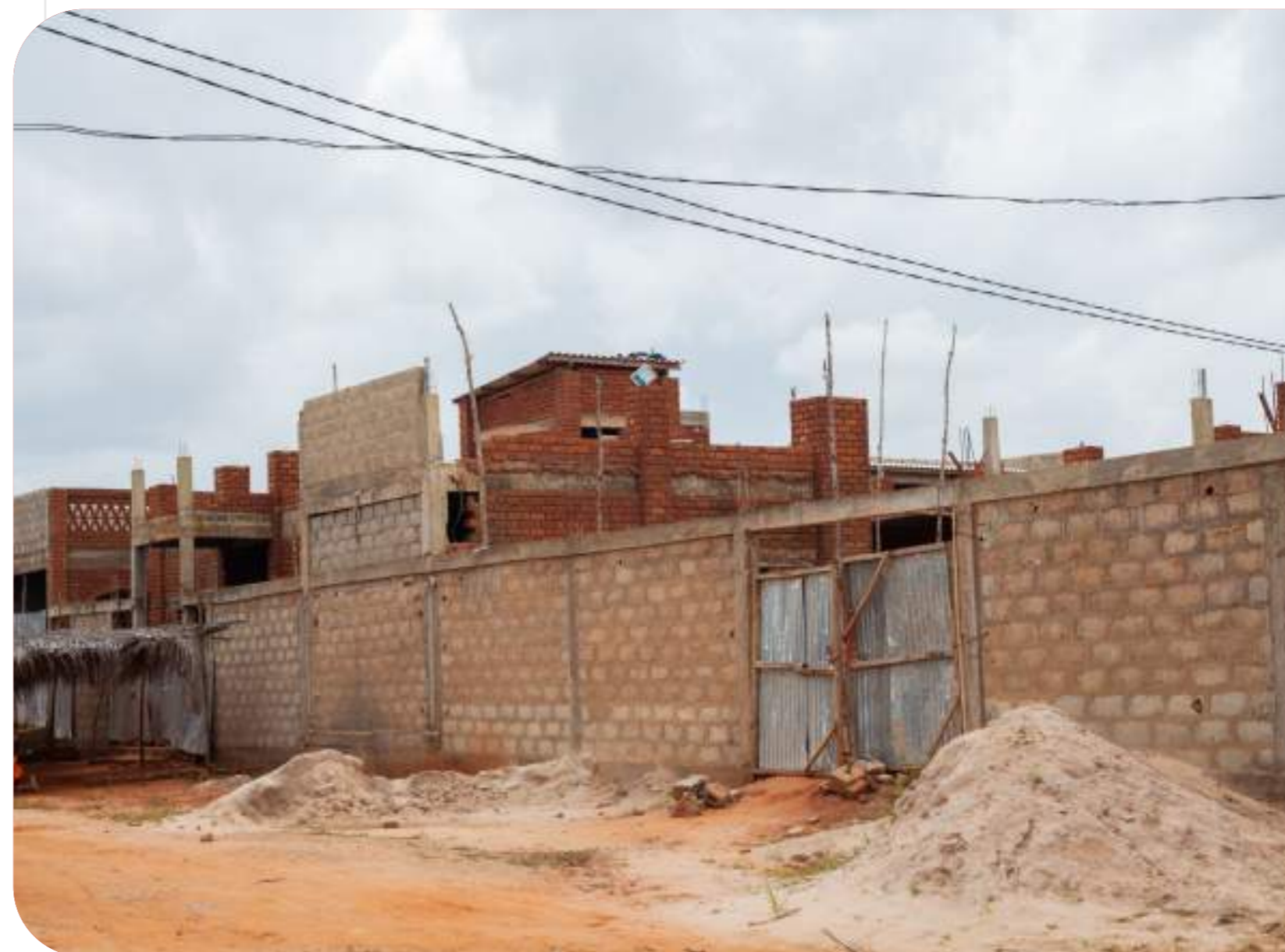
■ Nouveau foyer d'hébergement en construction.
